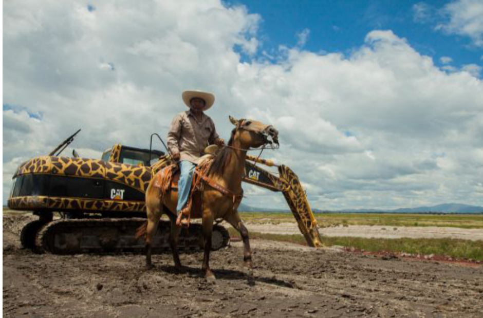
Maquinaria en los terrenos ejidales donde se busca construir el nuevo aeropuerto
