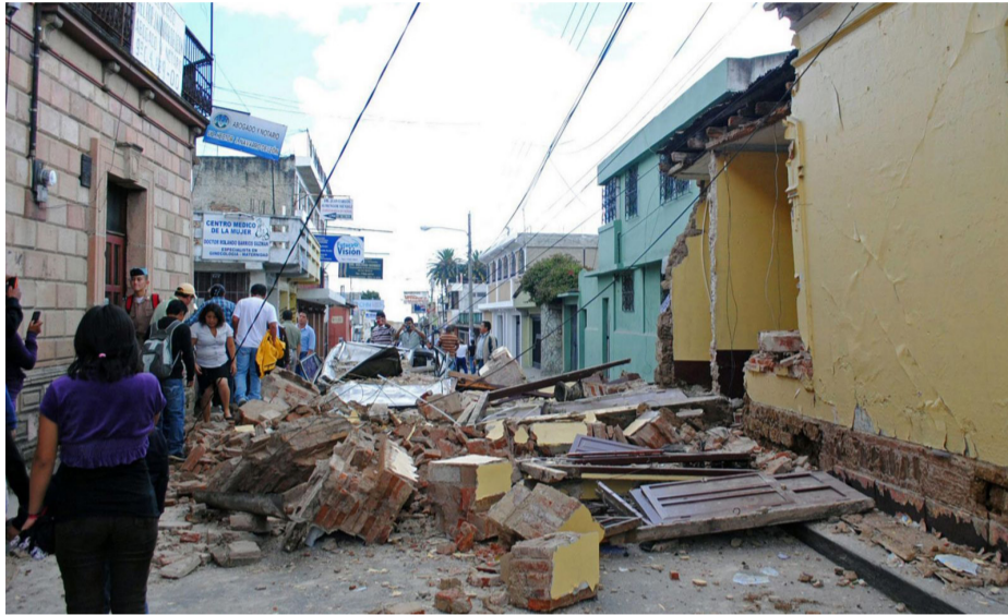
Estragos dejados por el sismo en Chiapas
